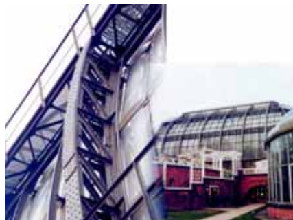
Tropenhaus im Botanischen Garten mit Ausschnitt der Altstahlkonstruktion
