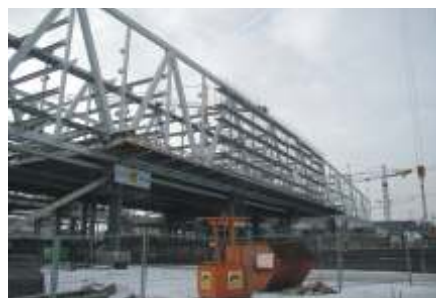
Parkhaus - Ansicht zum Flughafen
