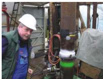
Durchstrahlungsprüfung an einer Förderrohrleitung mit IR 192
